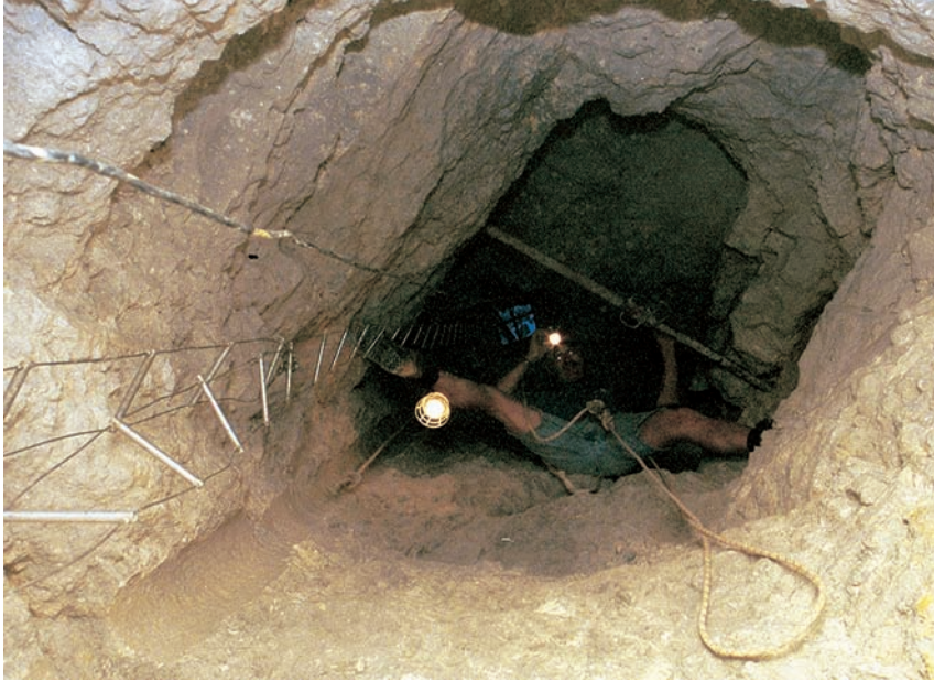
Photographie 4 : Le chantier en juin 2003, on remarque à gauche la trace du forage initial. Cliché Patrick Morand.
